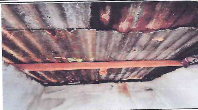
SUSTITUCION DE LAMINA POR LAMINA TROQUELADA
