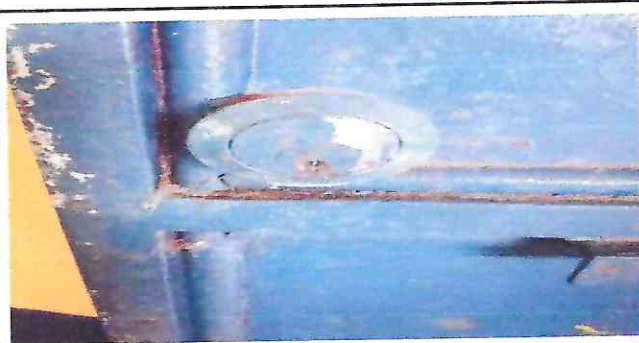
SUSTITUCION DE CHAPA
