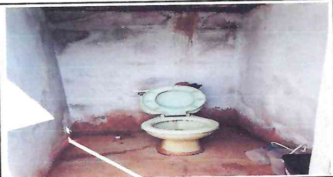
SUSTITUCION DE INODORO
