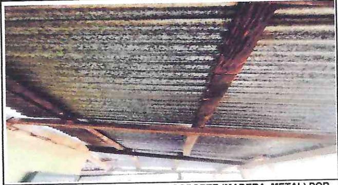
SUSTITUCION DE ESTRUCTURA DE SOPORTE (MADERA, METAL) POR METAL
