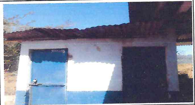
SUSTITUCION DE PUERTA E SERVICIOS SANITARIOS
