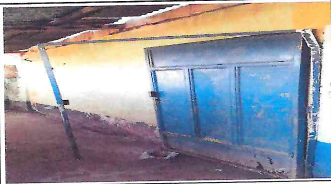
SUSTITUCION DE PUERTA
