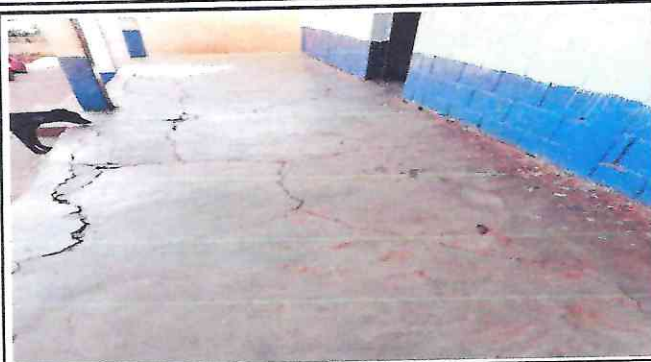
SUSTITUCION DE PISO CERAMICO
